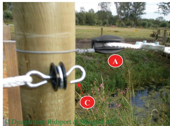
Stakettrådarna avslutas i kraftiga hörnisolatorer "A" avsluta inte stakettråden i grindisolatorerna "C", dessa är inte tillräckligt hållbara och är inte avsedda att hålla hela stängseltrådens belastning.
